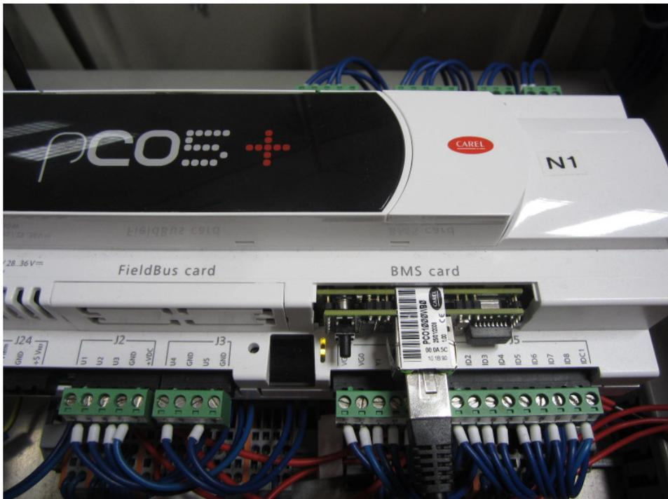
Bild Nr. 1 eingesteckte optionale BACnet Web Server Interface Karte bei der Airtronic Regelung
